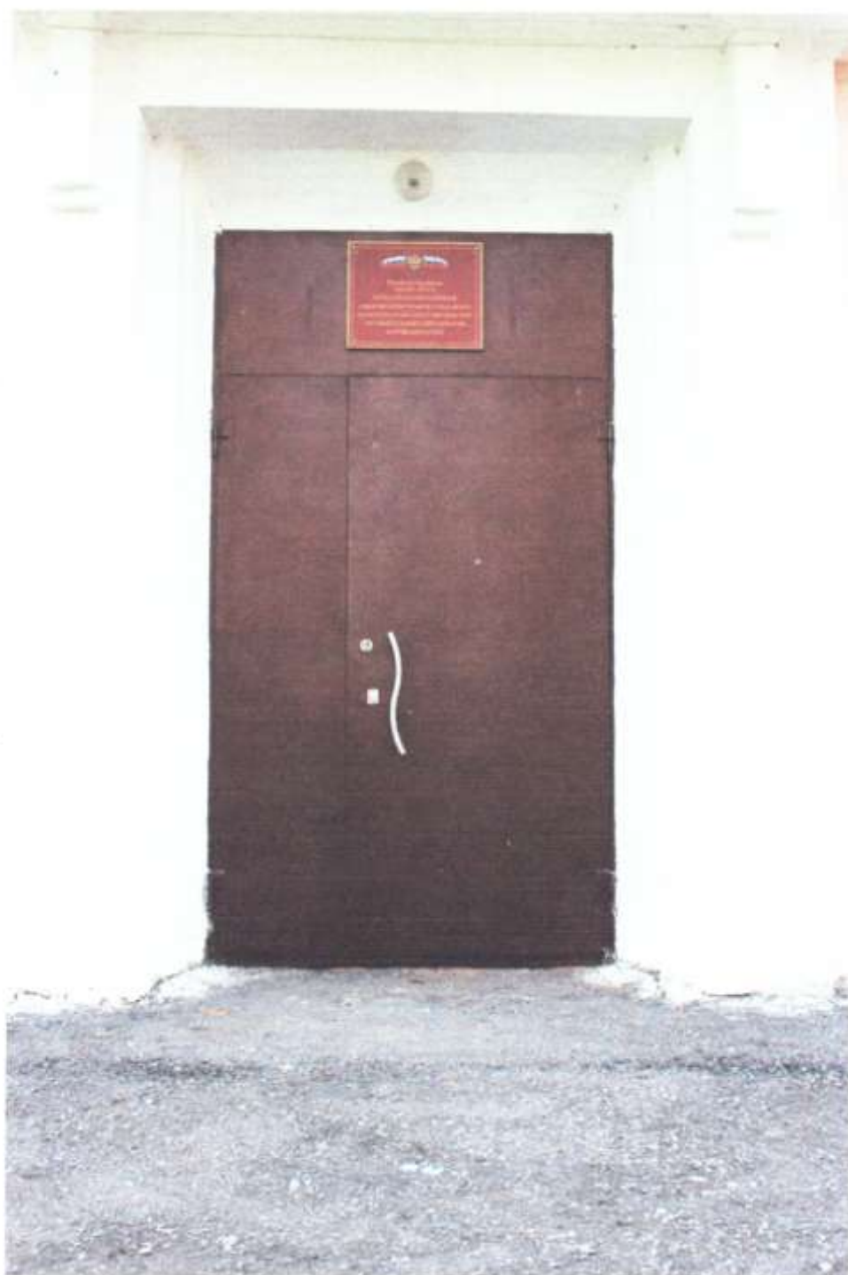
Фото № 6 Вход в здание ОУ
