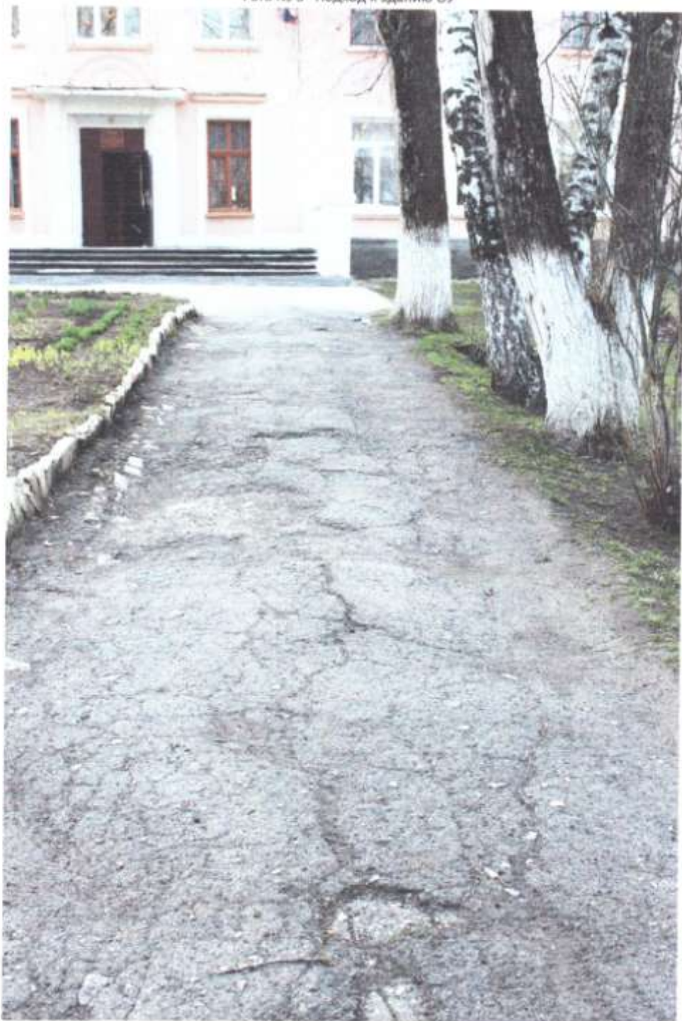
Фото № 3 Подход к зданию ОУ
