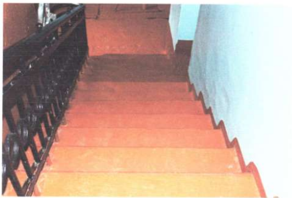
Фото № 11 Лестничные марши
