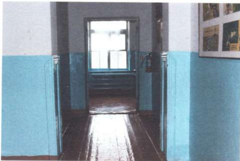
Фото № 12 дверные проемы
